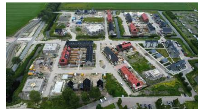
Remmerdel (Landsheer) in aanbouw
